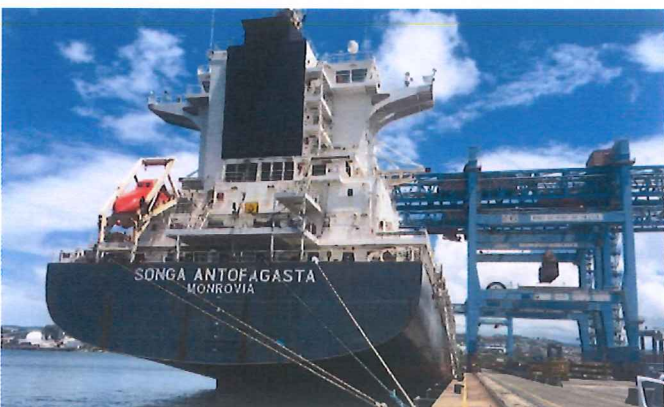
Les travaux d'allongement du quai principal du terminal de la pointe des Grives devraient débuter en 2019.
